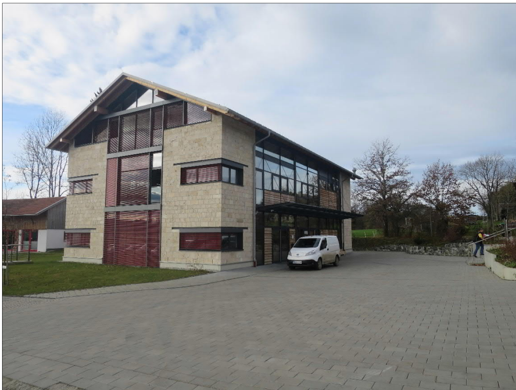
Abb. 3: Anwesen Feichtmayrstraße 17a - Neubau Fertigungs-/Montagegebäude mit Büro-/Sozialräumen, Lager und Anlieferung sowie Tiefgarage
