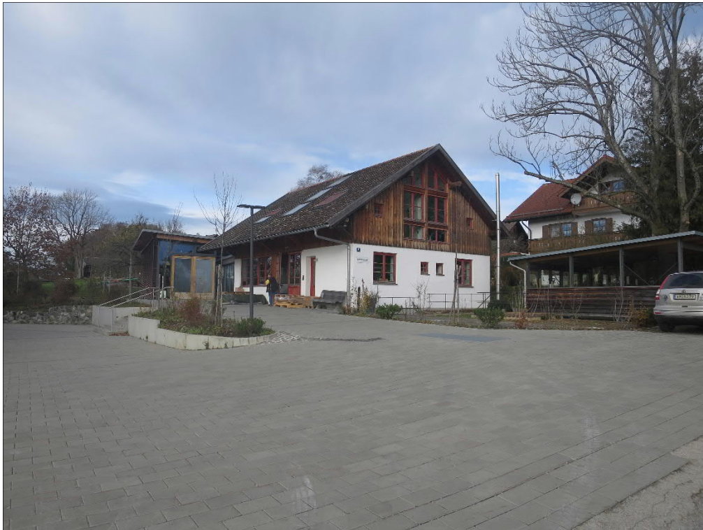
Abb. 2: Anwesen Feichtmayrstraße 17 - Altbau Fertigungs-/Montagegebäude Nr. 2 mit Anbau Montageraum
